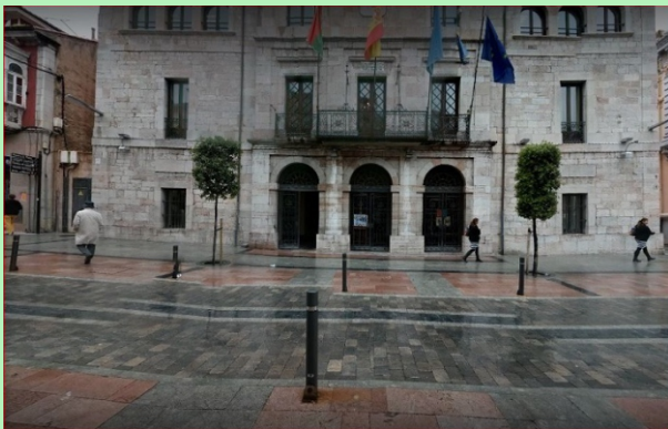
Ayuntamiento de Llanes: Edificio en GRIOTTE Pavimentación de calle con el mismo material en Baldosa Abujardada
