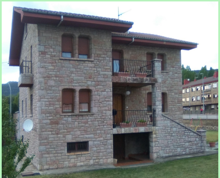
Mampostería Concertada de Caliza cortada a tamaños distintos.
