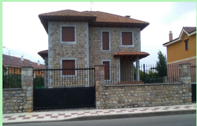
Mampostería Concertada de Caliza Cortada a tamaños distintos con esquineros y enmarcaciones de Caliza Serrada.
