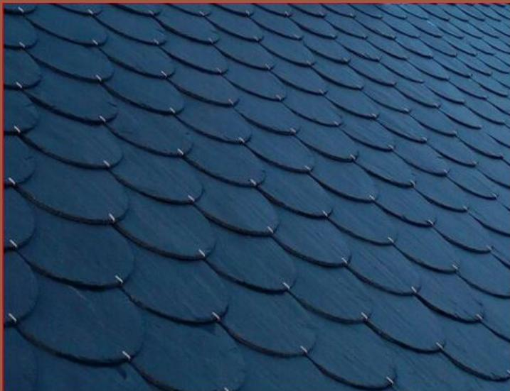
Lajas o Placas dimensionadas a espesor de 7 a 9 mm.
